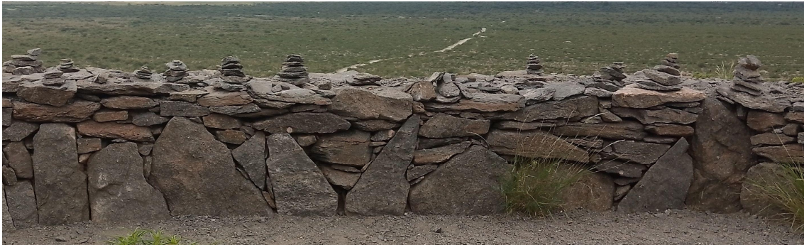
Figura 15. Detalle de la Figura 14. Nótese los huecos entre las piedras que componen la pirka
