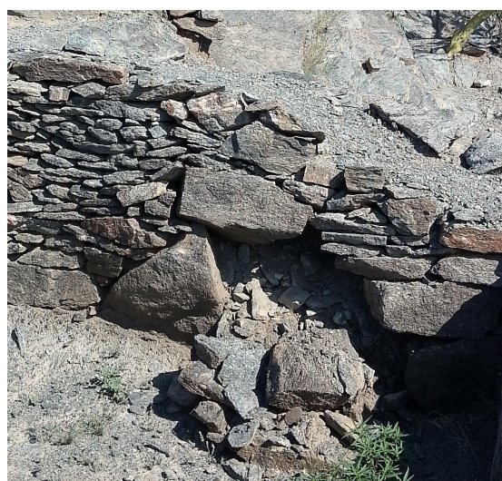
Detalles del deslice a la izquierda y del desplome a la derecha
