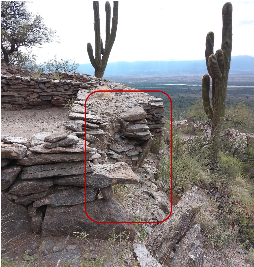
Figura 16. El recuadro rojo señala el área de desplome de la pirka.
