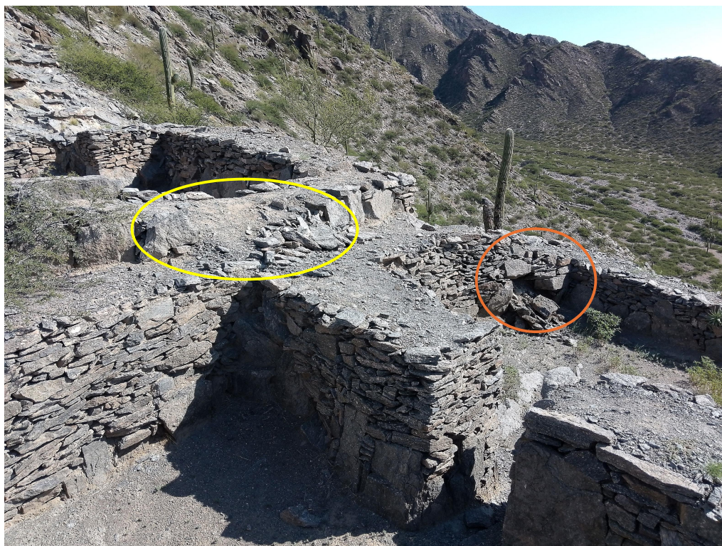
Figura 11. Deslice de material por pisoteo y desplome de la base de la pirka.
